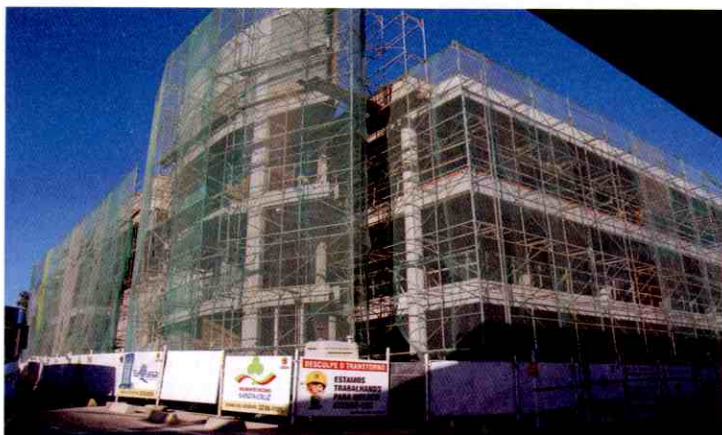
Obras do Shopping Cidade estão avançadas
